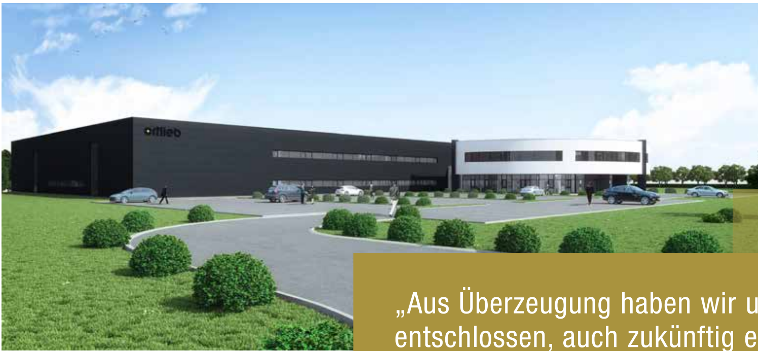
Moderne Industriearchitektur und Gebäudetechnik als wichtige Faktoren der Standortsicherung
