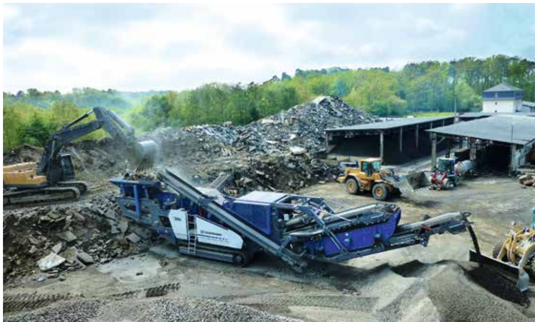
Der mobile Prallbrecher MR 130 Z EV02 beim Recycling-Einsatz
